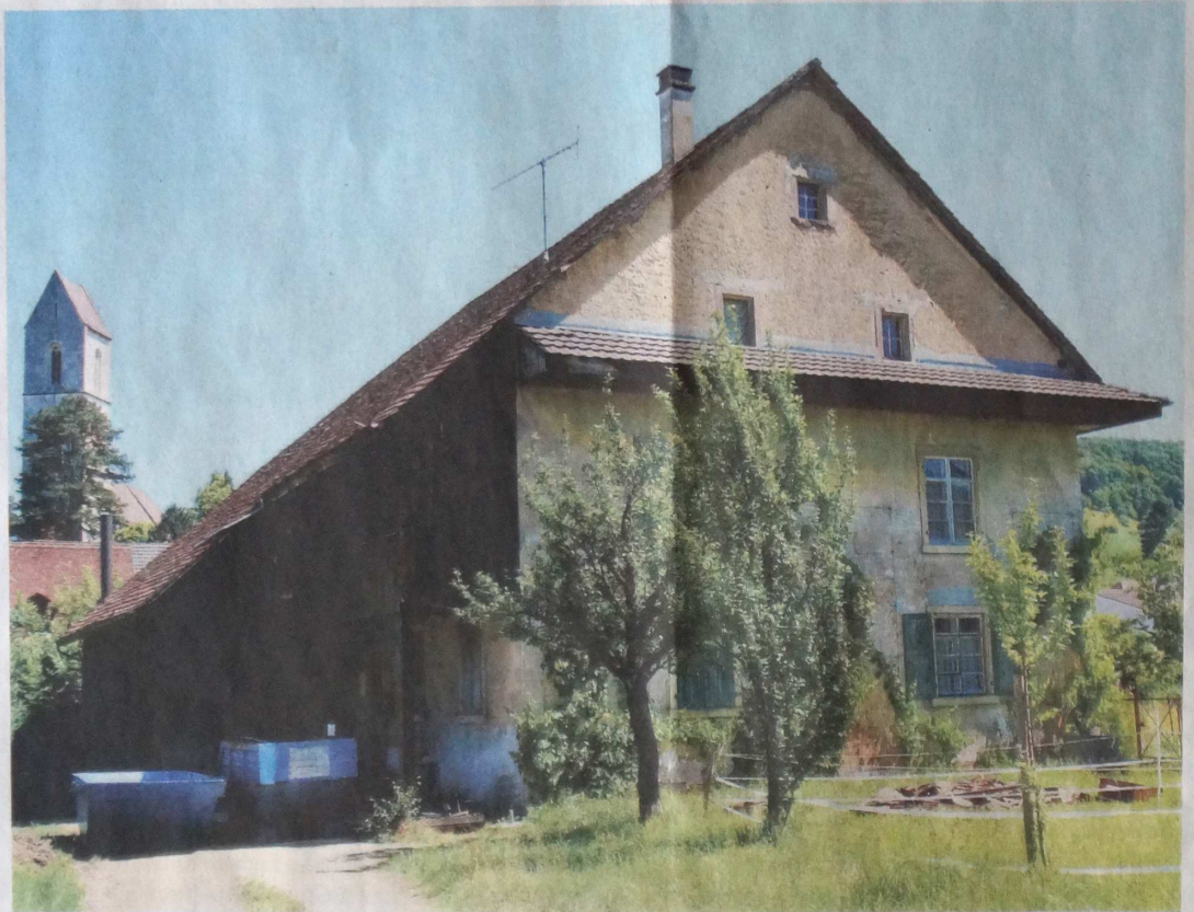
Dem Gelterkinder Jundt-Huus steht ein erneuter Umbau bevor.
